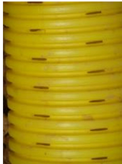
Pormenor da porosidade do tubo de drenagem
