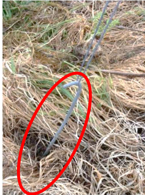
Tirante da hélice ligado ao poste através de arames c/ esticadores
