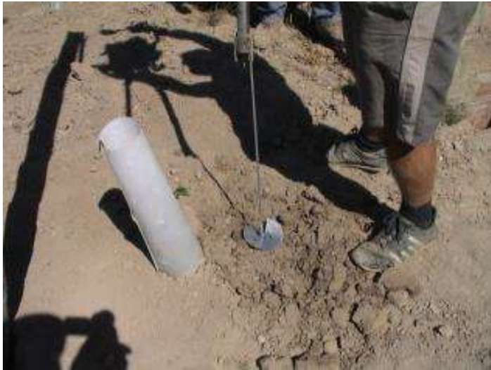
Arriosta de hélice e tirante
