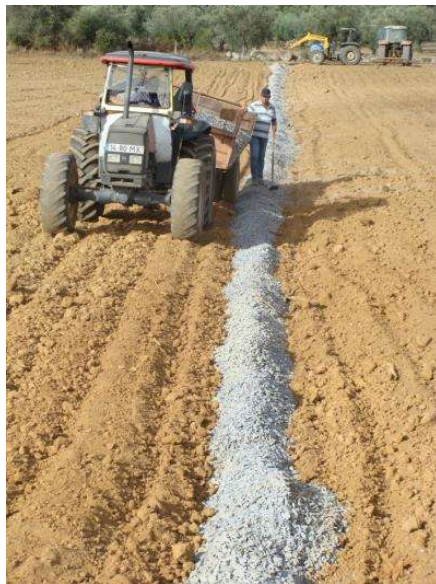
Aplicação de gravilha nas valas de drenagem
